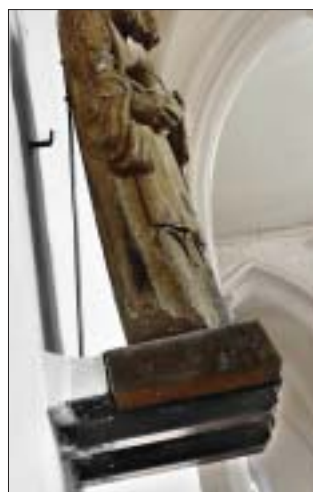
La statue est fixée au socle et stabilisée par une fixation à l'arrière.
